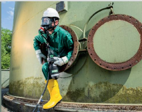
Per gli spazi confinati, dove esiste costantemente un alto rischio di emissioni pericolose, MSA propone respiratori Airline combinati dotati di un sistema di carrelli Airline per garantire la sicurezza sul lavoro. Se esiste il rischio di eventi pericolosi imprevisti, i dispositivi di fuga o gli autorespiratori a ossigeno sono l'ideale per aiutare i lavoratori ad allontanarsi dallo spazio confinato in caso di carenza di ossigeno o in presenza di atmosfera tossica.
